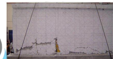
Falla por deslizamiento
